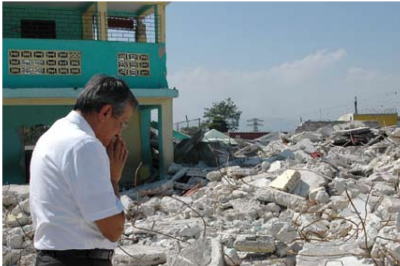
Pe. Chávez junto aos escombros da escola profissional ENAM de Port au Prince, onde ainda prosseguem as buscas da Protecção Civil italiana
